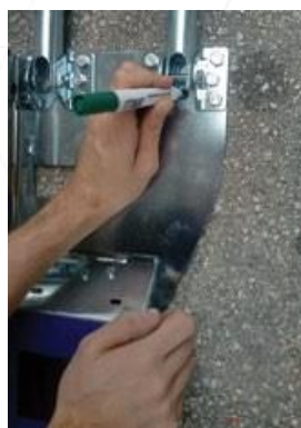
Figure 8 – Marquer les endroits où percer
